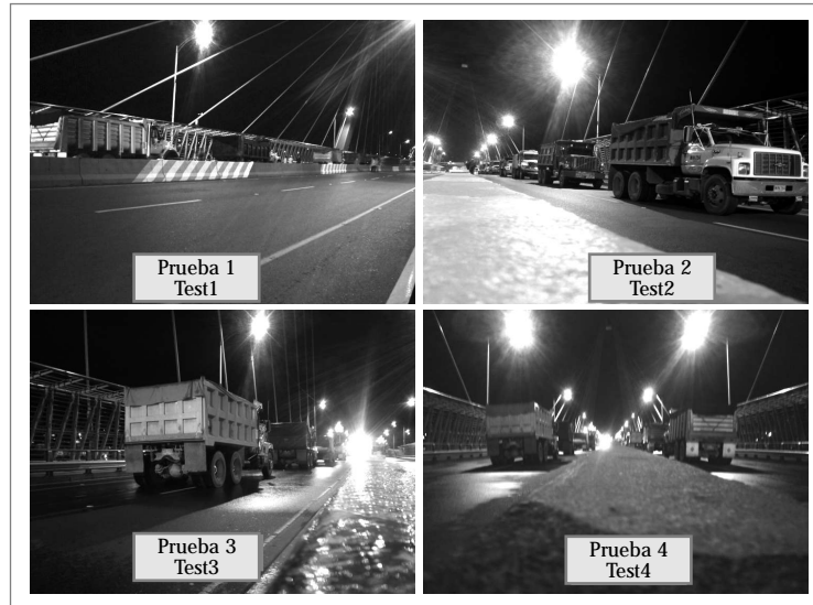
Figura 8. Fotografía de las cuatro (4) posiciones de las volquetas en la prueba de carga. (1) y (2) Excéntrica en el vano lateral y central del lado de Dosquebradas Figure 8. Picture of four (4) dumps positions for loading test (1) and (2) Eccentric stress on side and central span at Dosquebradas wing
