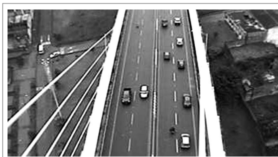
Figura 19. Video del tráfico de cámara 1, de luz lateral hacia Dos quebradas Figure 19. Traffic's video streaming, camera 1, side span towards Dos quebradas
