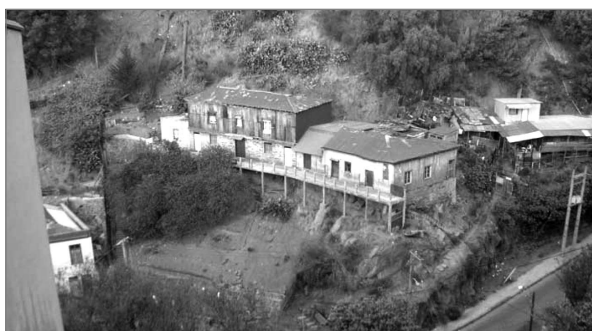
Figura 16. “Quebrada” en Valparaíso, con potencial riesgo de alud por derrumbe de tierras o barro
