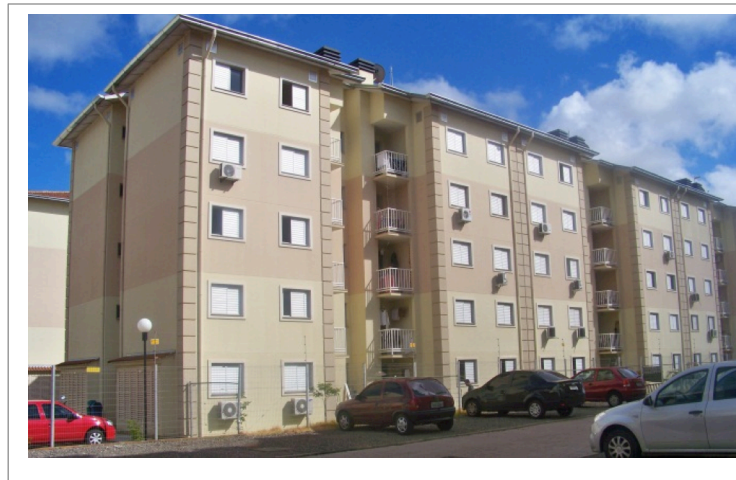
Figura 2. Vista de un bloque construido. Fuente: autores
