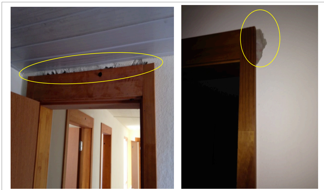
Figura 3. Ejemplos de problemas en la interface entre tapajuntas de madera y el revoque. Fuente: autores
