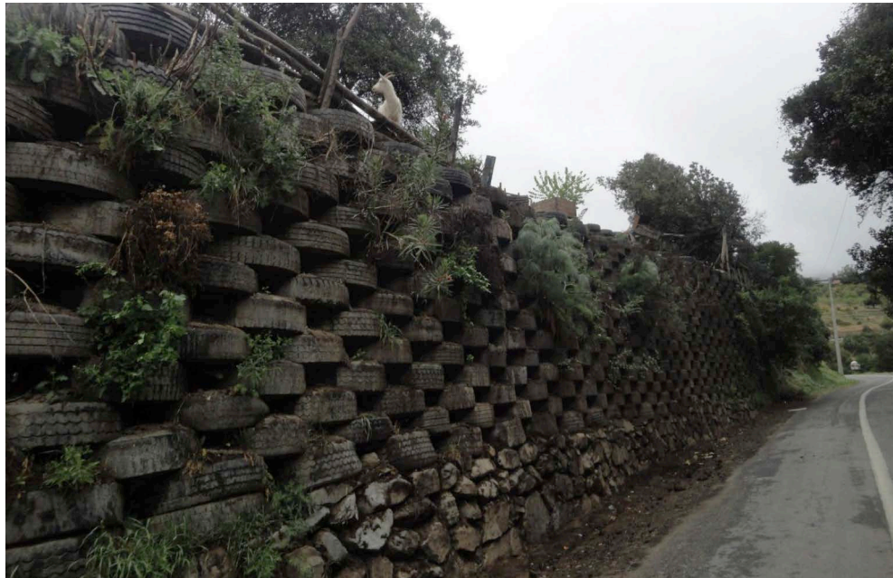
Figura 5. Muro de contención en el sector de La Vega, Olmué (Foto: cortesía de Tania Estay)
