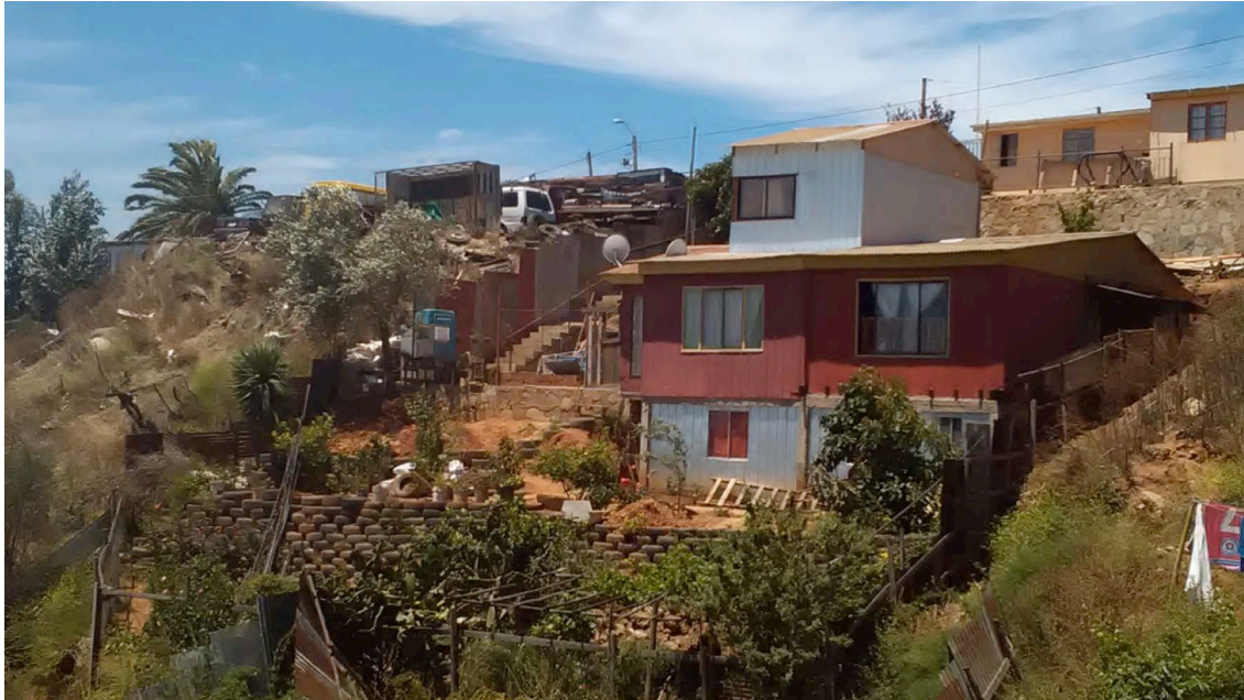
Figura 4. Muro de contención en el Cerro Las Cañas, Valparaíso (Foto: cortesía de Claudio Peña)
