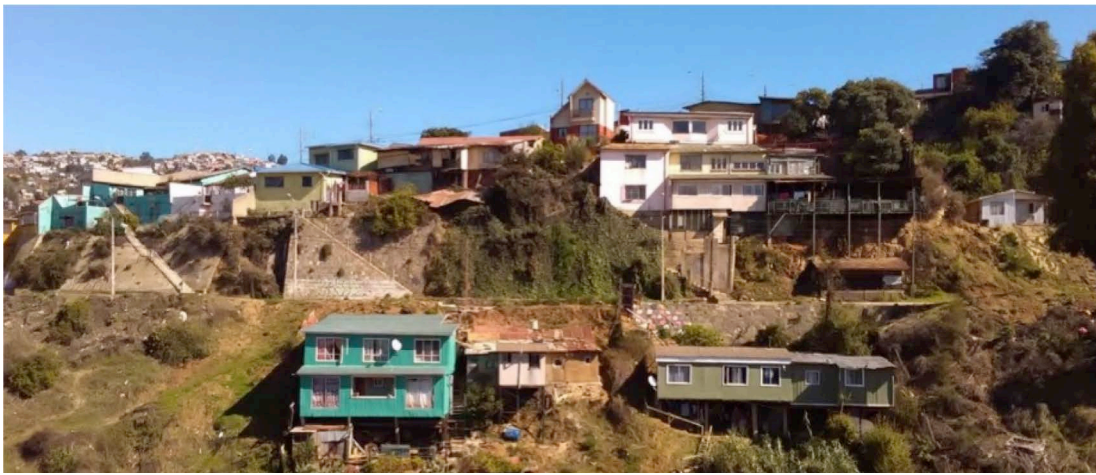
Figura 2. Viviendas construidas sobre terreno retenido por muros y sobre pilares, Valparaíso (Fuente desconocida)
