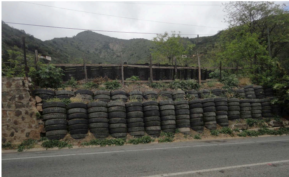
Figura 6. Muro de contención en sector "Medialuna de La Dormida", Olmué (Foto: Gustavo Sarabia)
