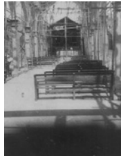
Proceso de construcción del Templo
