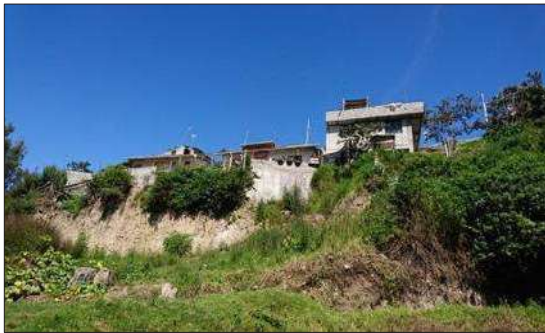
Imagen 9 Vivienda en zona de riesgo quebrada en Lumbisí Fuente: PACHA estudio
