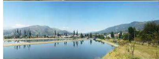
Imagen 21 Central Hidroeléctrica Cumbayá Fuente: https://www.youtube.com/watch?v=qqNB1b46Lug
