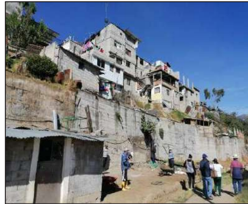
Imagen 8 Vivienda en zona de riesgo quebrada en Lumbisí Fuente: PACHA estudio
