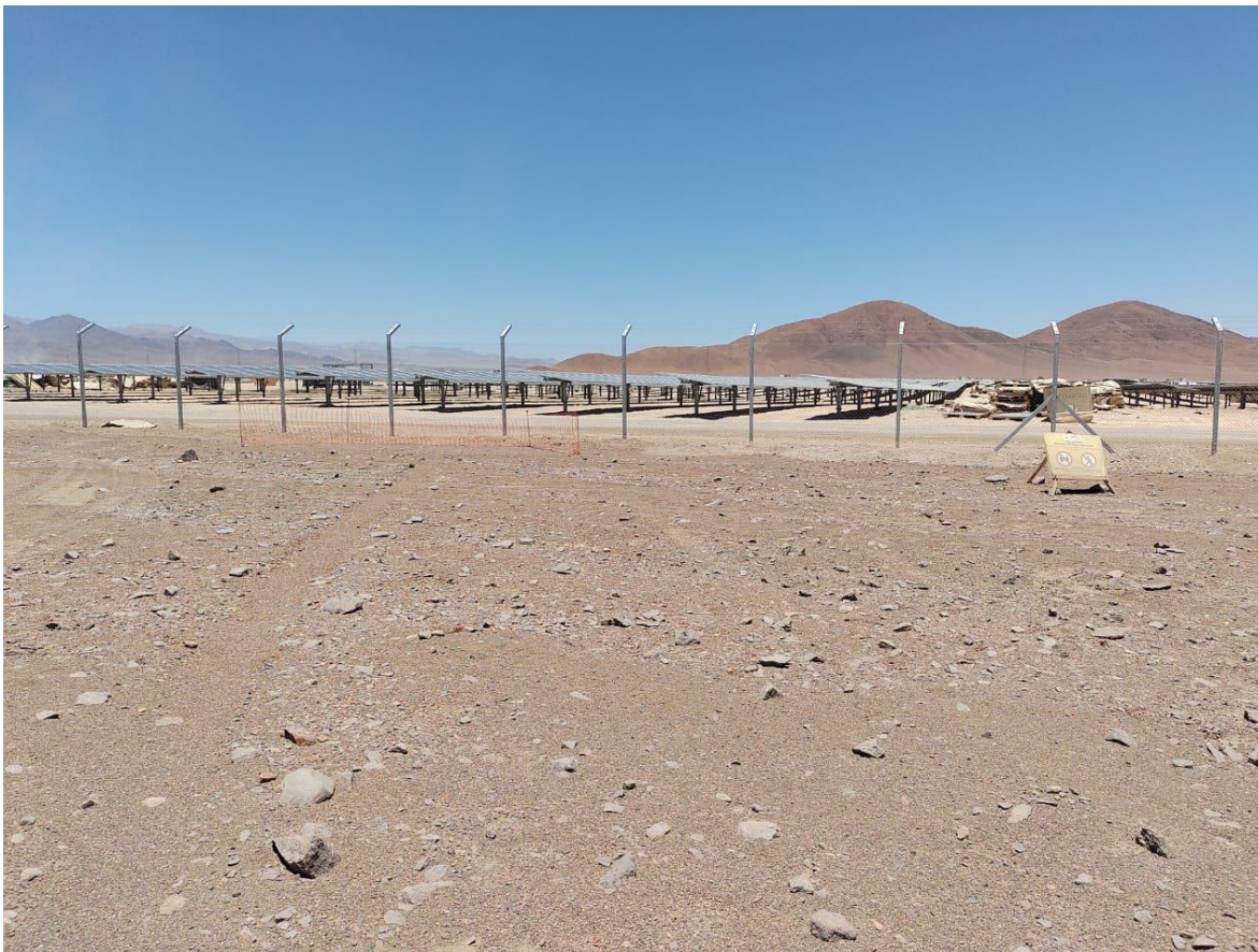
Vista Del Perimetro Del Proyecto Del Titular Colbun Costado Norte, Con Direccion Al Sur, Donde Aparece La Red Vial Del Camino Del Inca Despues De Desarecer En El Proyecto Del Titular Colbun S.A
