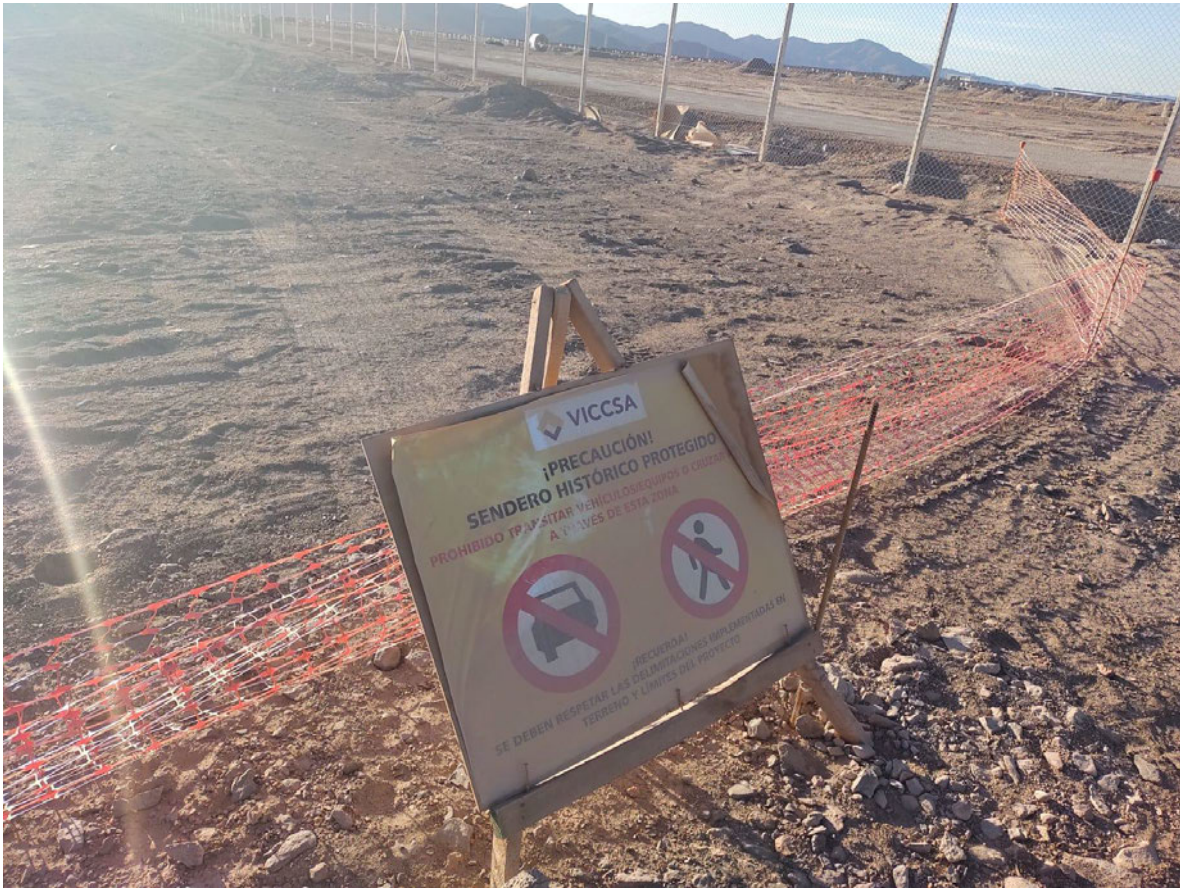
Vista Sur Del Proyecto Del Titular Colbun, Donde Se Aprecia Letrero De Precaución Por Sendero Historico, El Cual Desaparece Al Ingresar Al Proyecto.
