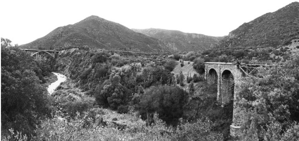
FIG. 06: Puente ferroviario río Colorado. Fuente: fotografía de Sandra Iturriaga.
