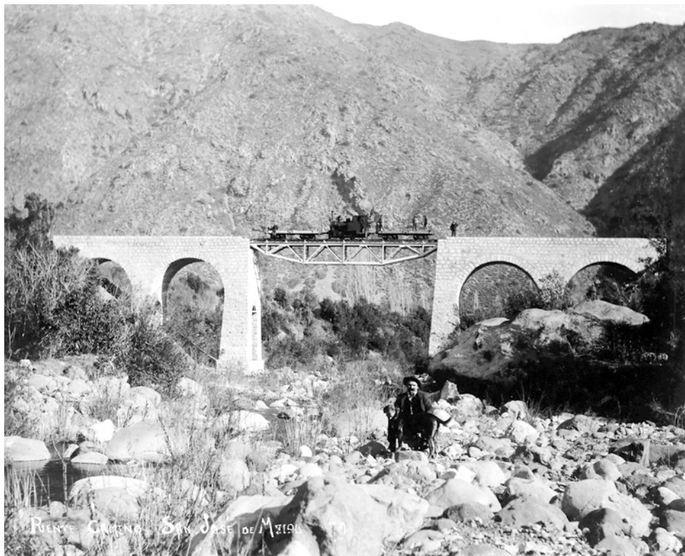
FIG. 02: Puente El Manzano Ferrocarril Militar, 1908. Fotografía Odber Heffer "Puente Camino San José de Maipo". Fuente: Fondo Documental Cultura Digital Cenfoto, UDP
