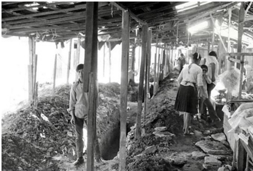
Figura 5. Ejecución de trabajos en un mercado provisional 1970
