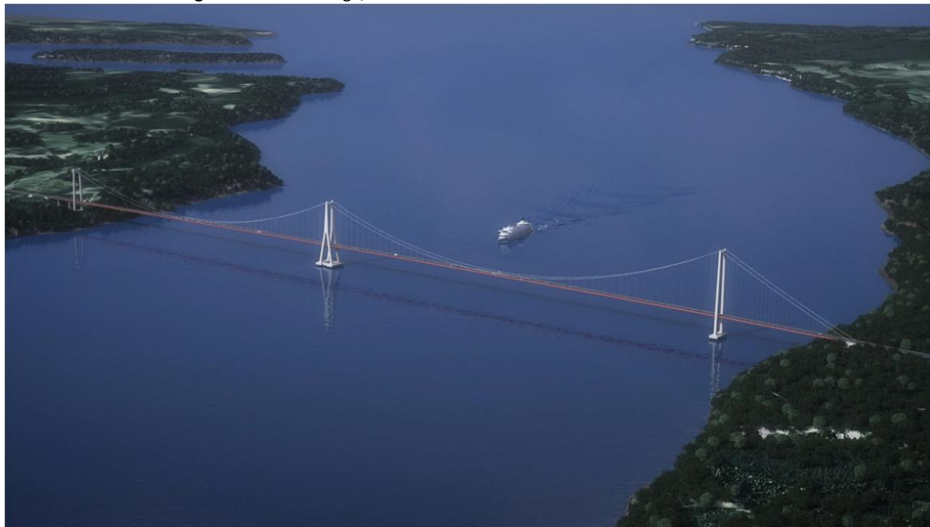
Figure 1. Chacao Bridge, Chile. Source: Ministerio de Obras Públicas de Chile.
